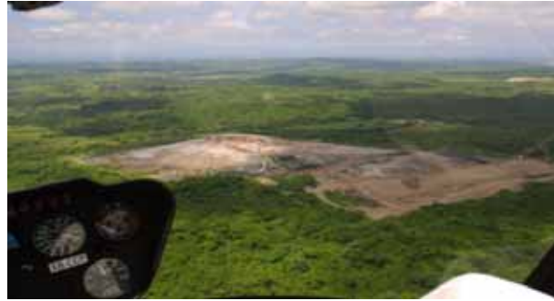
Toma del tiradero de basura de la ciudad de Veracruz en donde se aprecia una incompatibilidad de usos, lo que provoca que los vientos dominantes del norte vallan directos a las zonas habitacionales de reciente creación y a las propuestas en esta estrategia, motivo por el cual se propone la reubicación de dicho tiradero.
