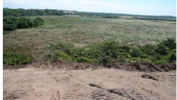
Vista parcial del vaso regulador de la Laguna Villarín, al fondo se aprecia la corriente del río Grande, nótese la invasión de las terracerías del fraccionamiento hacia el vaso regulador.
